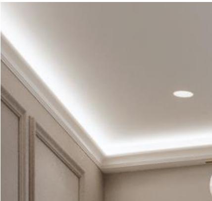
Потолок натяжной тканевый. Крепление стандартное, карниз с подсветкой
